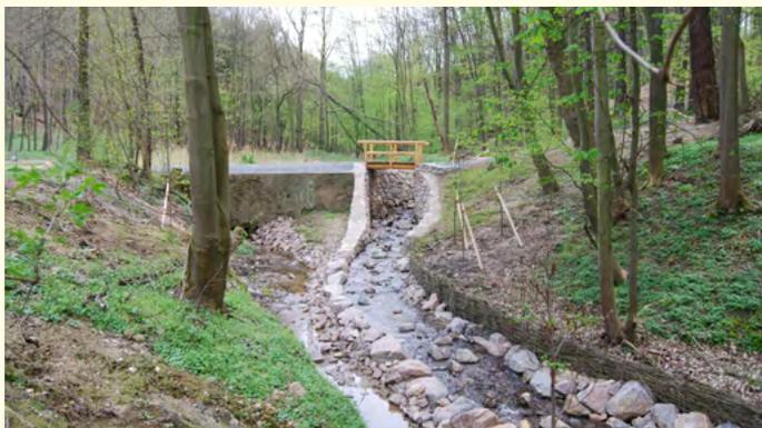
↑ Ergebnis des Rückbaus der Staustufe an der Bockau – Wiederherstellung der Durchgängigkeit für die FFH-Fischart „Bachneunauge“. Foto: Lutz Runge
